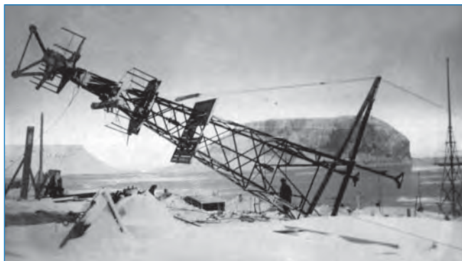
Подъем башни ветродвигателя Д-12. Фото Б.А. Кремера (РГАЗ, ф. 572, оп. 1, д. 63, л. 112).
