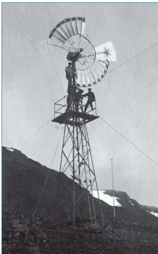
Демонтаж ветродвигателя в б. Тихая в 1936 г. (РГАЭ, ф. 9570, оп. 2, д. 1320, л. 84).
