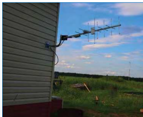
Антенна спутникового радиотерминала на станции Мудьюг Северного УГМС.
