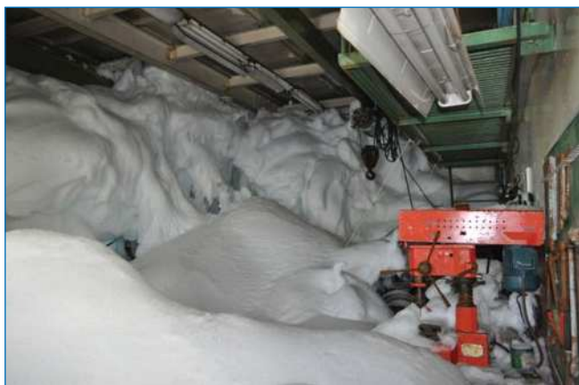
Станция Русская. Машинный зал в здании дизельной электростанции, полностью заполненный льдом через выдавленные ветром окна (2008 г.) (слева).
