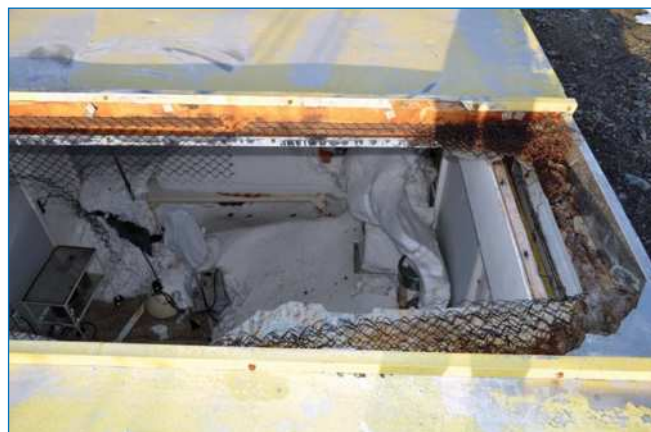
Станция Русская. Машинный зал в здании дизельной электростанции, полностью заполненный льдом через выдавленные ветром окна (2008 г.) (слева).
