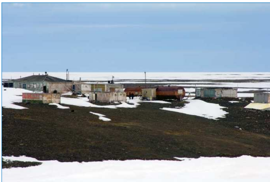
Комплекс сооружений станции «Мыс Баранова».
