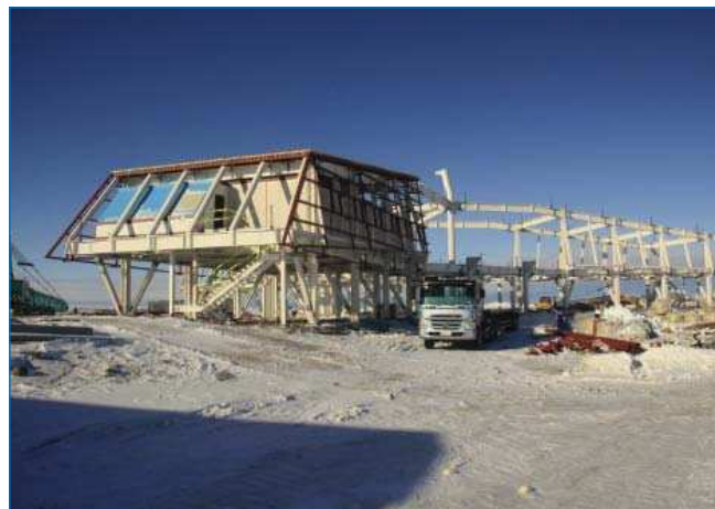
Монтаж здания станции. 3 марта 2013 г. Фото О.Фоломеева.
