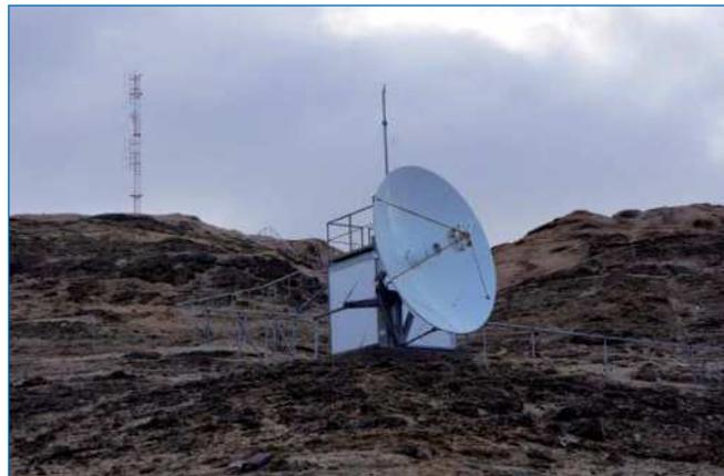
Приемные антенны спутникового и радионавигационного комплекса.
