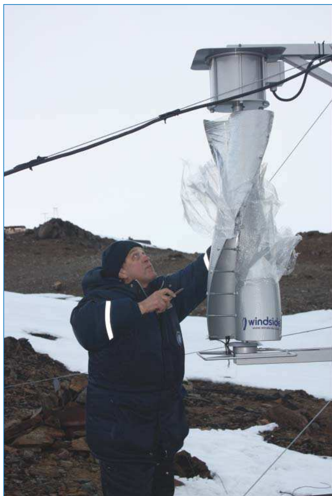
Установка ветрогенератора для автоматической метеостанции Русская
