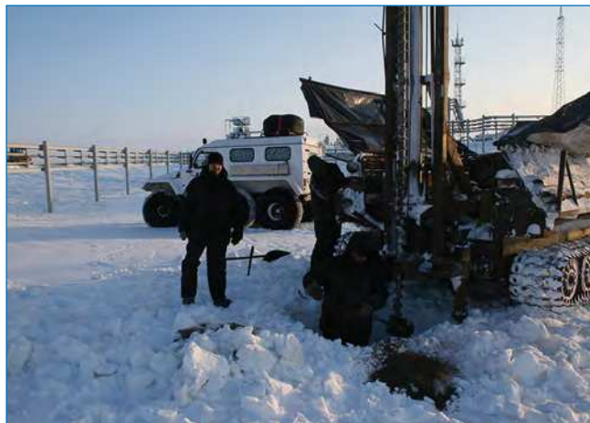
Установка сейсмодатчика на полуострове Ямал.
