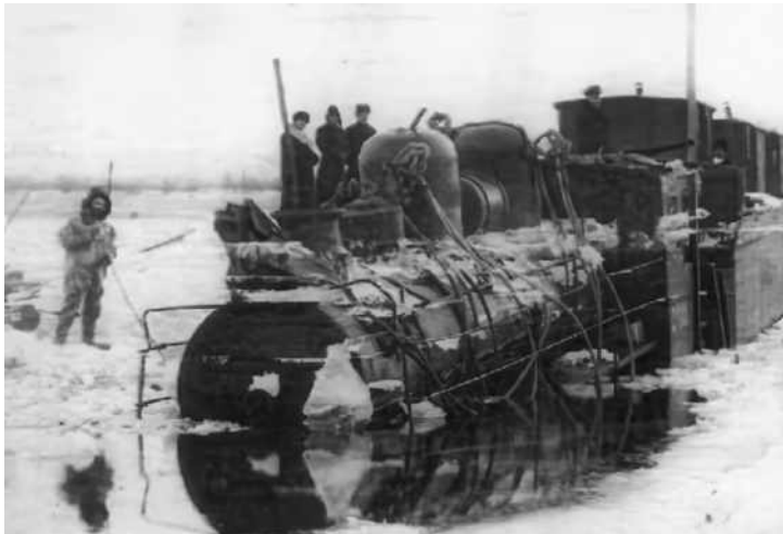
Рис. 3. Авария на ледовой переправе через р. Амур.
