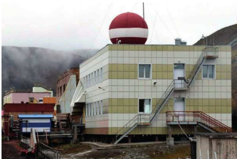
Рис. 1. Лабораторный корпус РНЦШ в Баренцбурге после реконструкции
