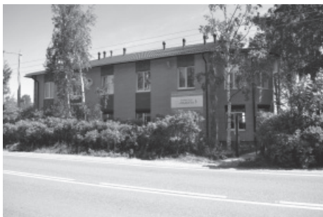
Учебно-гостиничный корпус ПБ «Ладога» со стороны подъезда по трассе А 128.
