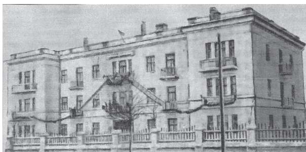
Рис. 1. Здание АНИИ в Красноярске в 1941–1944 гг.
