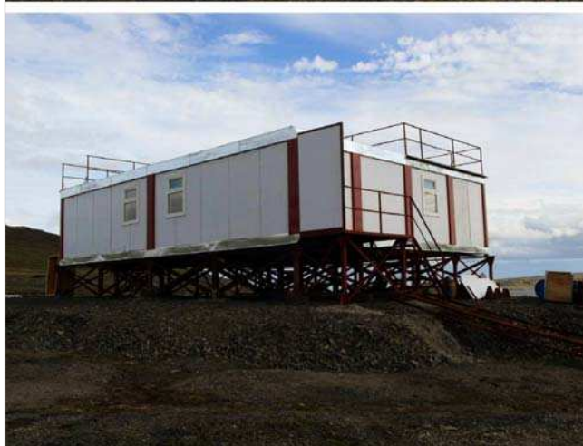
Рис.1. Общий вид здания ЛЧВ
