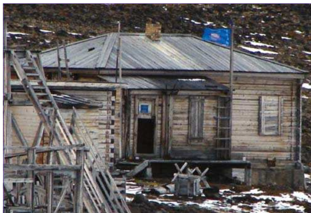
Здание биостанции ММБИ в бухте Тихой на о. Гукера Земли Франца-Иосифа. Фото А. Илющенко
