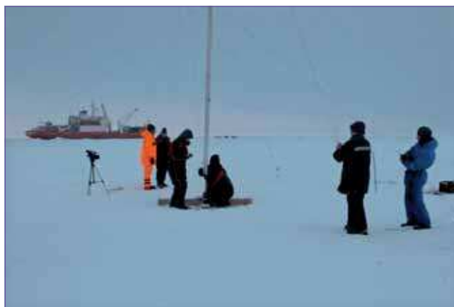
Монтаж оборудования метеоплощадки
