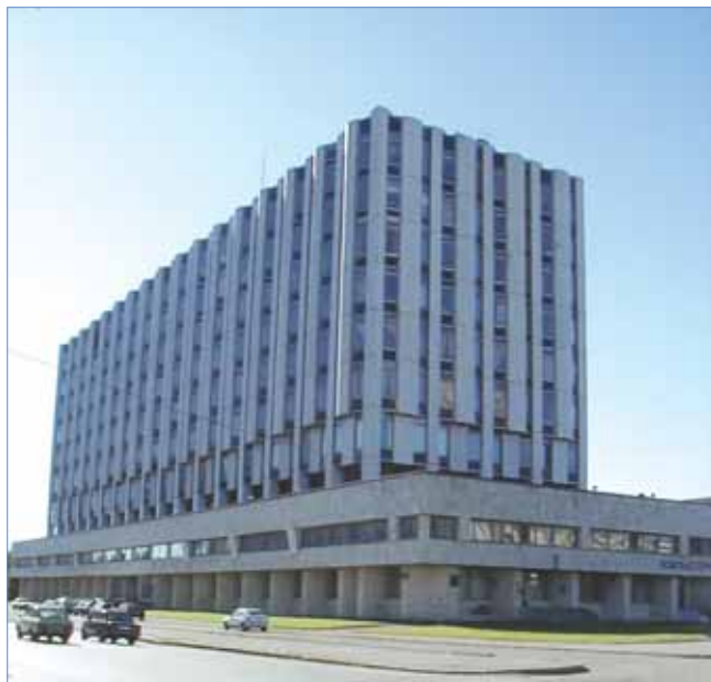
Здание ААНИИ, г. Санкт-Петербург
