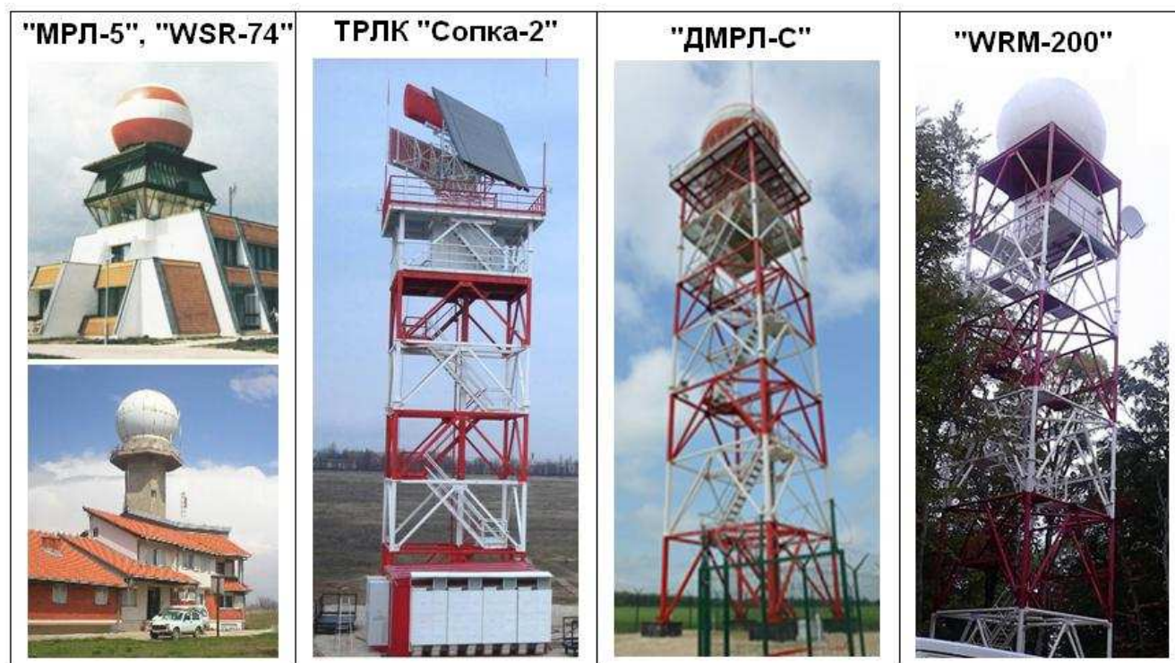
Рис. 12.3 – Радиолокаторы «МРЛ-5», «WSR-74», ТРЛК «12А6», «ДМРЛ-С» и «WRM-200», информация которых может обрабатываться программным обеспечением «АСУ-МРЛ» [9]
