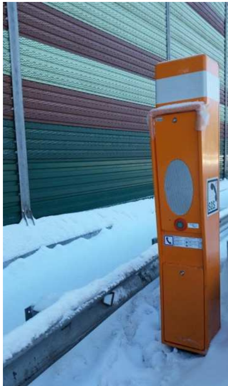
Рисунок 79 – Внешний вид АВК производства «MAITRISE TECHNOLOGIQUE»
