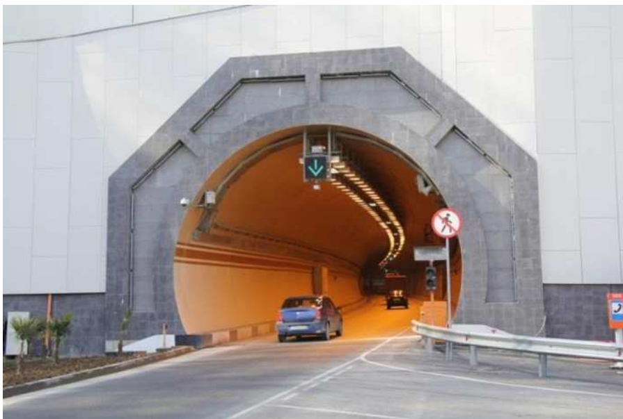
Рисунок 95 – Въезд в автодорожный тоннель Дублера Курортного проспекта
