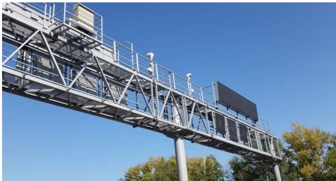
Рисунок 32 – Пример установки видеокамер на П-образной опоре
