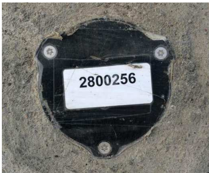
Рисунок 107 – Пример установки парковочного датчика
