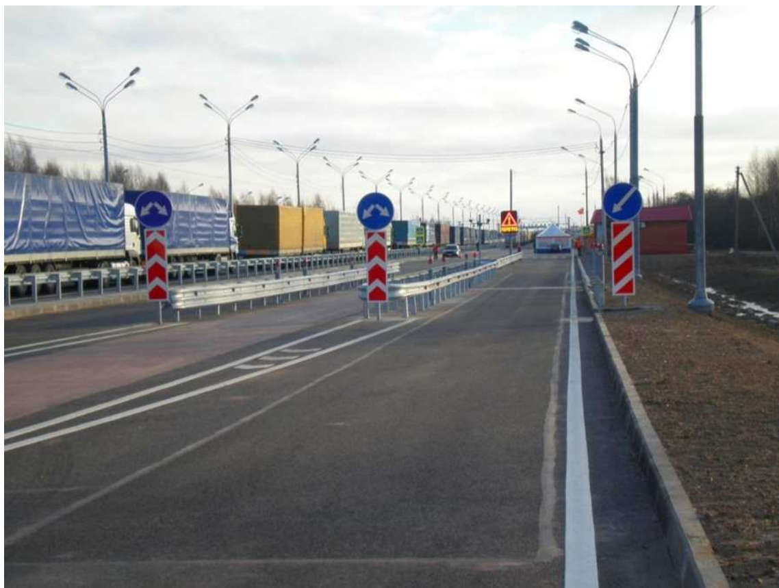
Рисунок 67 – Пример установки пункта весового контроля
