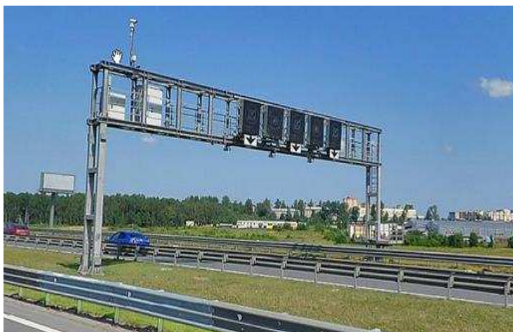
Рисунок 41 – ЗПИ на Кольцевой автомобильной дороге
