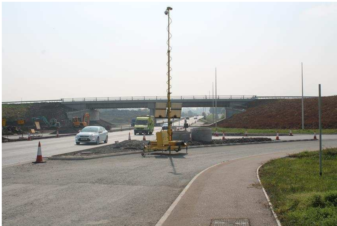
Рисунок 35 – Пример применения мобильного видеокomплекса
