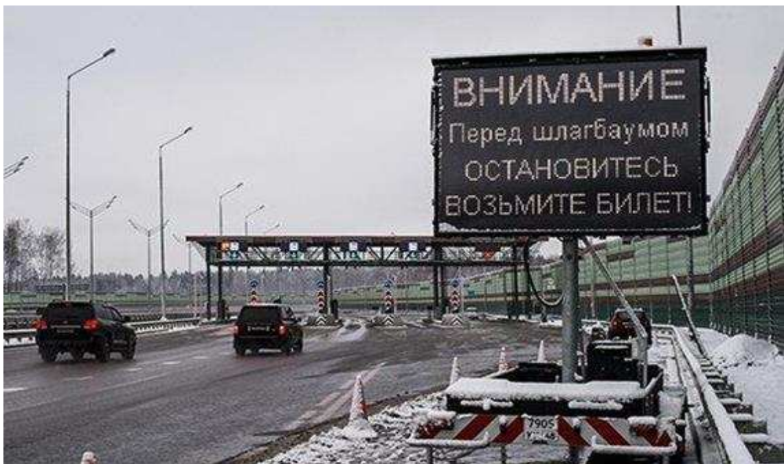
Рисунок 54 – Пример применения мобильного ДИТ на автомобильной дороге М-11
