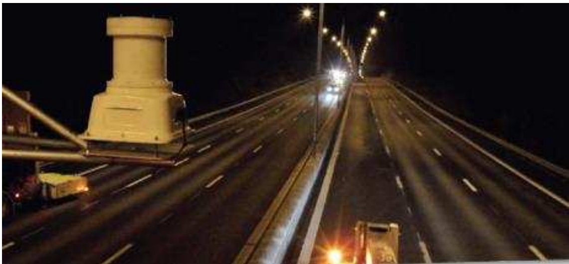
Рисунок 75 – Пример установки радара на разделительной полосе
