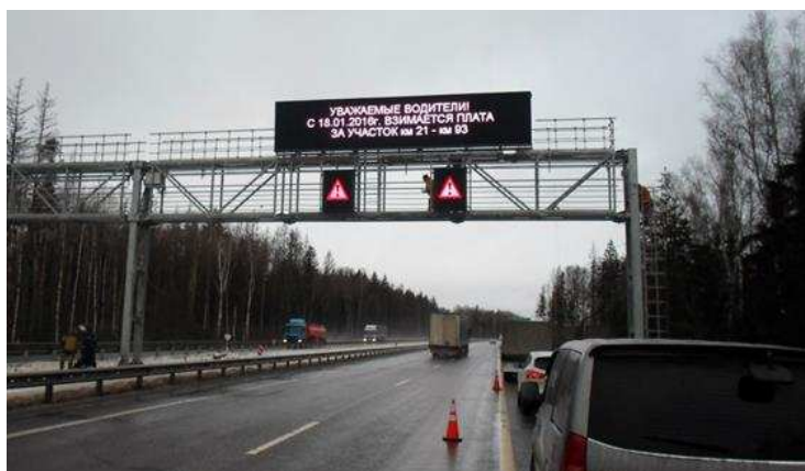
Рисунок 39 – Пример установки полноматричного динамического информационного табло и ЗПИ на автомобильной дороге М- 4 «Дон»
