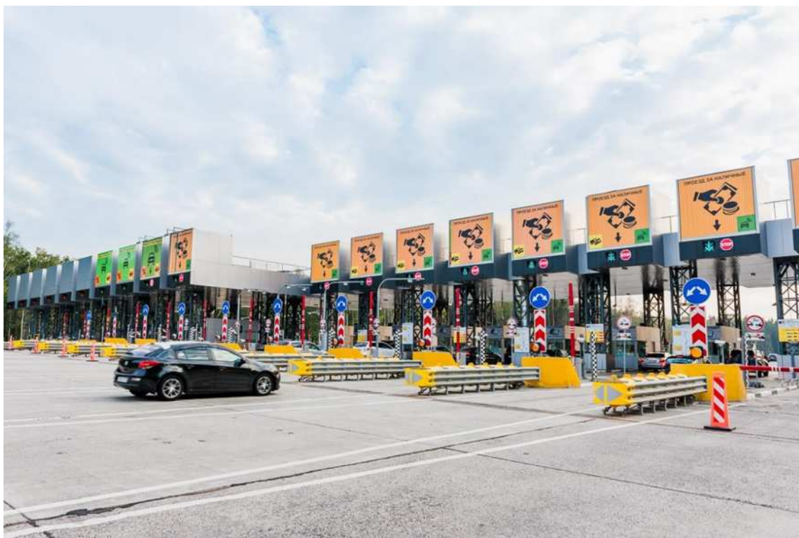
Рисунок 45 – Пример применения электромеханических информационных знаков на пункте взимания платы 6,9 км М-1 «Беларусь» («Северный обход Одинцово»)
