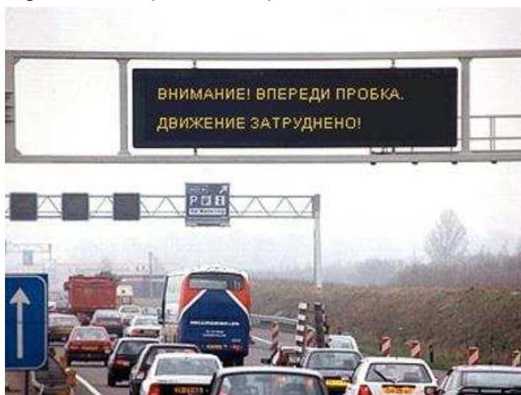
Рисунок 37 – Пример динамического информационного табло, состоящего только из текстового модуля
