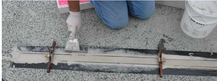
Рисунок 62 – Монтаж WIM-сенсора
