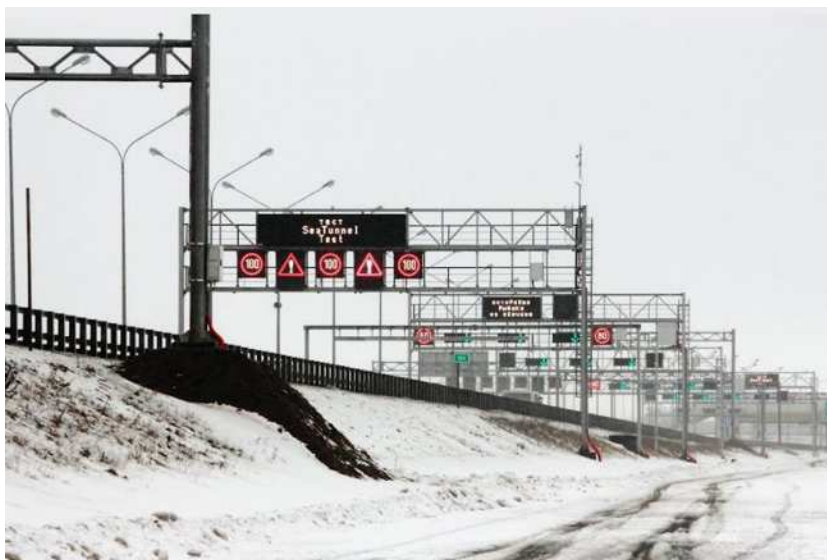
Рисунок 7 – Пример управления движением по основному ходу автомагистрали на подъезде к тоннелю судопропускного сооружения С-1 КЗС (снимок из Google Earth)
