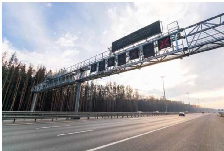
Рисунок 36 – Пример установки ДИТ и ЗПИ на автомагистрали
