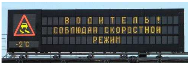
Рисунок 38 – Пример динамического информационного табло, состоящего из текстового и графического модулей
