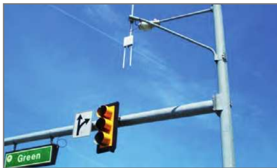
Рис. 60. Пример установки придорожного оборудования кооперативной ИТС в Анн-Арборе, Мичиган
