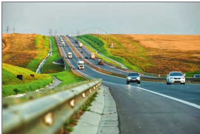
Рис. 23. Автомобильная дорога М-4 «Дон», 250-й км
