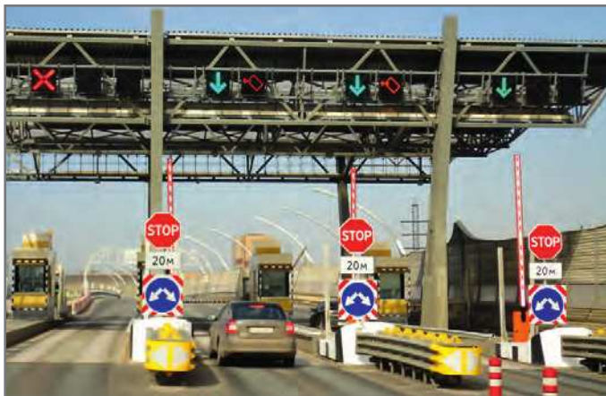
Рис. 72. Пункт взимания платы в районе ул. Благодатной на ЗСД (Северный участок)
