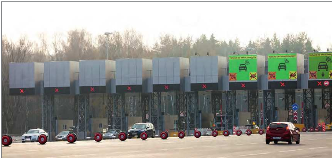
Рис. 27. Пример ПВП с возможностью переключения полос оплаты
