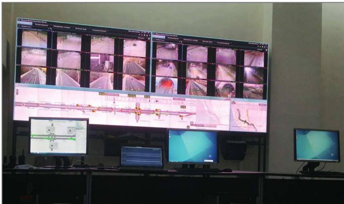
Рис. 20. Внешний вид видеостены Центра управления АСУДД Дублера Курортного проспекта. Программное обеспечение «Интеллект-Траффик»
