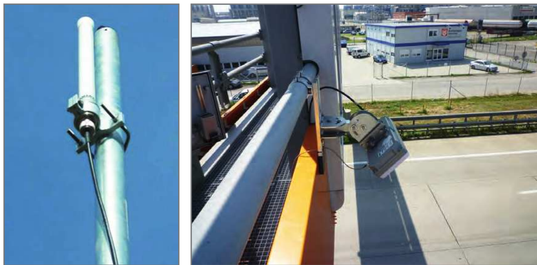
Рис. 57. Примеры внешнего вида придорожного оборудования (RSE)
