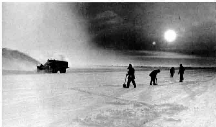
Фото 59. Расчистка ВВП и забутовка приливных трещин на льду лагуны о. Жохова
