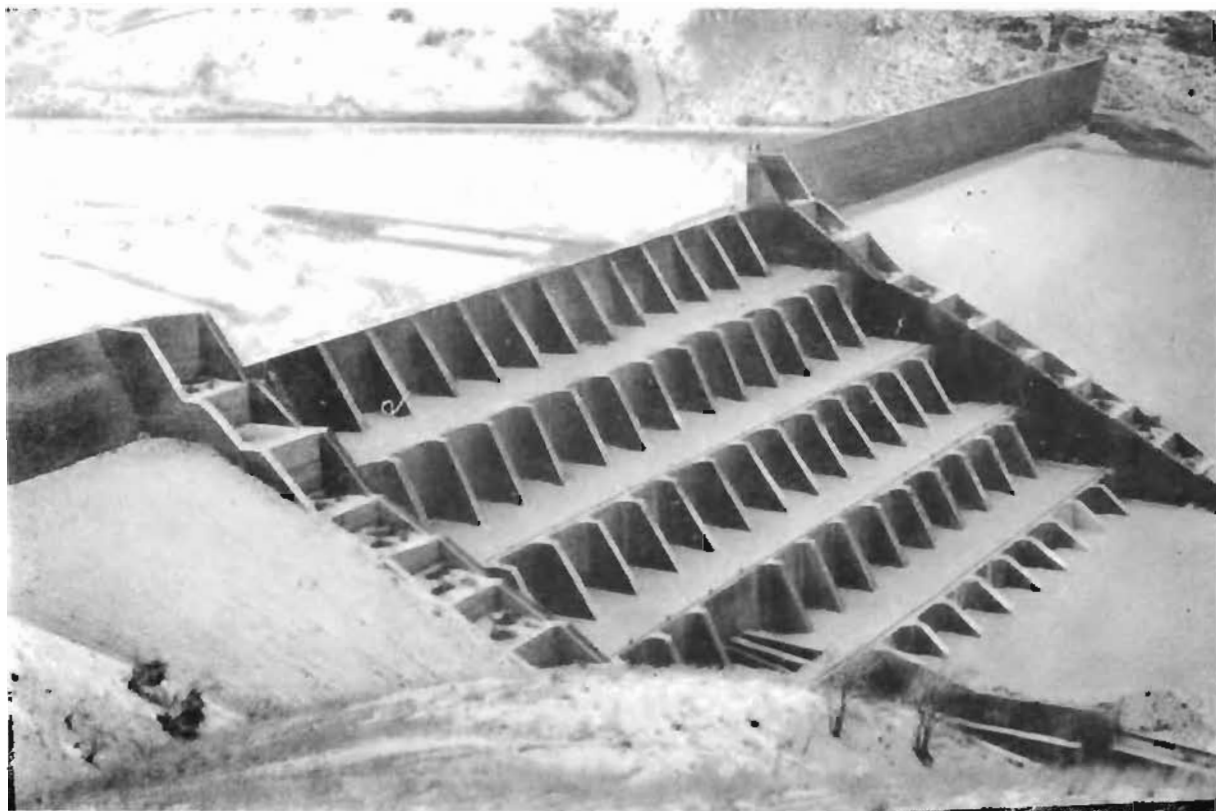
XXV. 45. Один из видов противоселевых сооружений: селезадерживающая ячеистая подпорная запруда в долине р. Б. Аламатки на Западном Алтае
