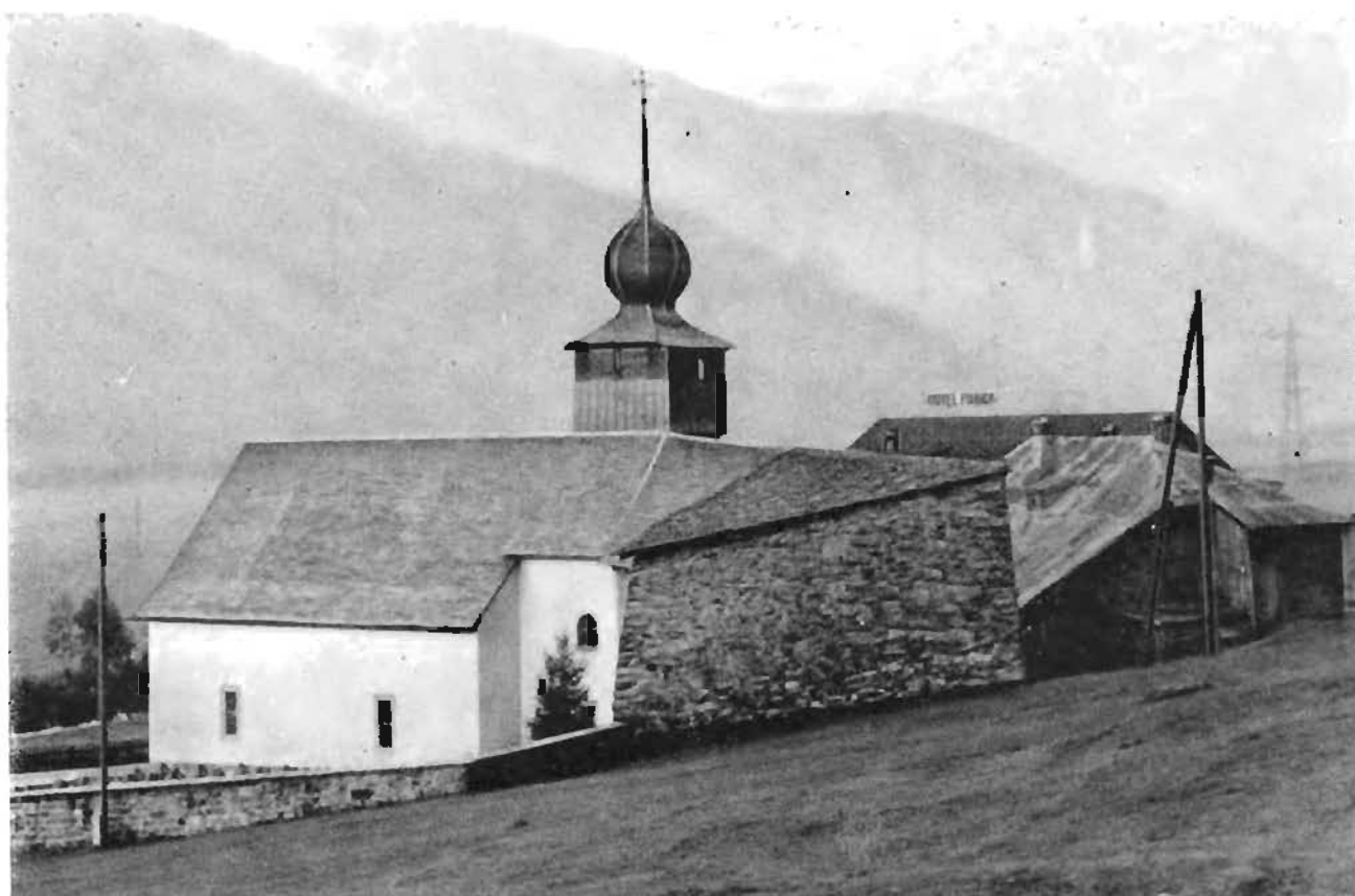
XIX. 33. Задняя стена старинной церкви в деревне Обервильд в Швейцарских Альпах, построенная в форме лавинореза.
