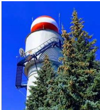
Рисунок 2. ДМРЛ-С Уфа, установленный на крыше водонапорной башни.
