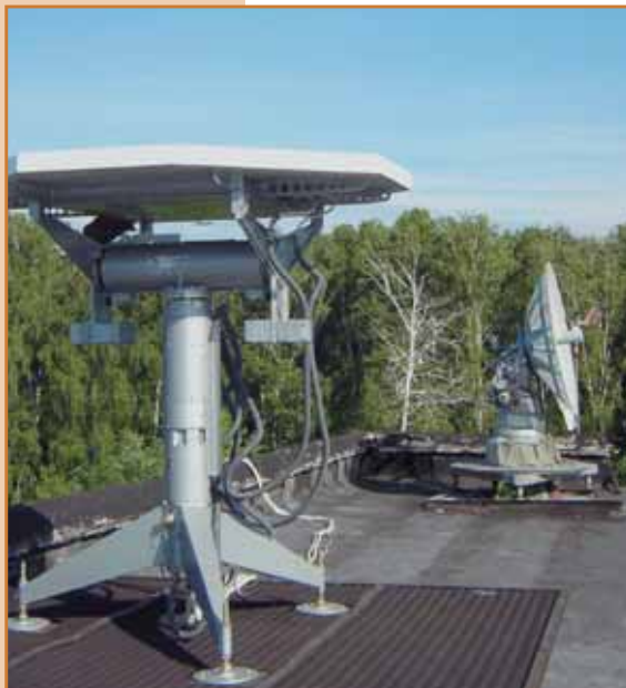
АЭ Новосибирск (на переднем плане – антенна Вектор-М, на заднем – антенна АВК).
