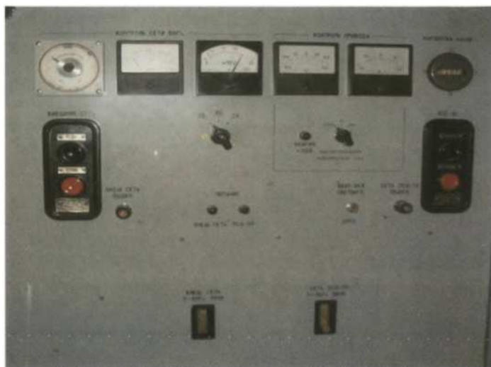
Рис. 20. Распределительный щит
