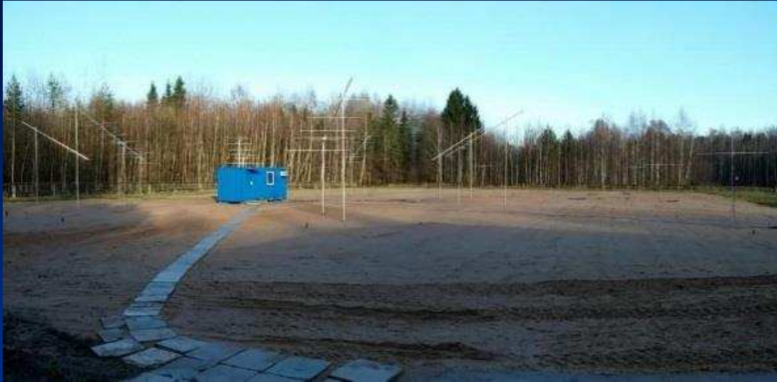
Антенное поле и аппаратный бокс метеорной РЛС
