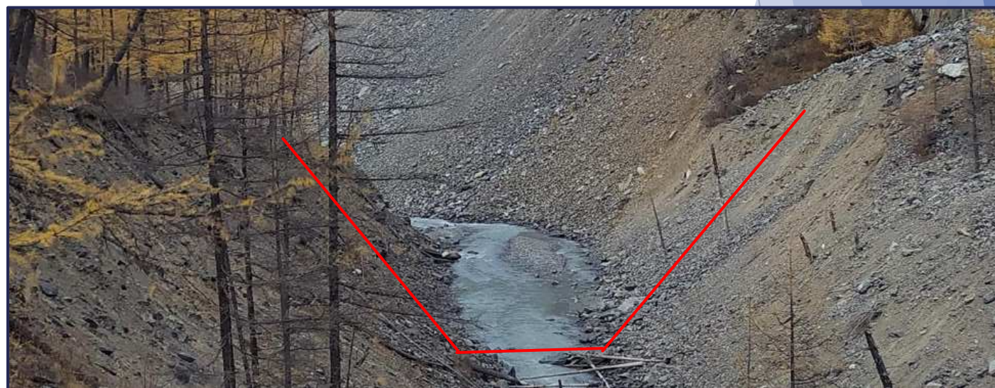
Проран в теле моренной плотины. Фото Распутиной В.А.
