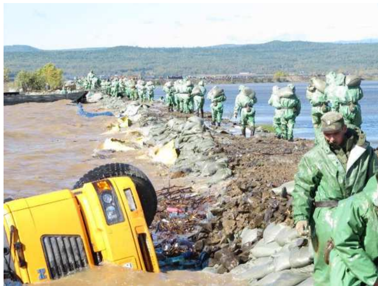
Укрепление Мылkinsкой защитной дамбы мешками с песком (г. Комсомольск-на-Амуре, сентябрь 2013 г.)
