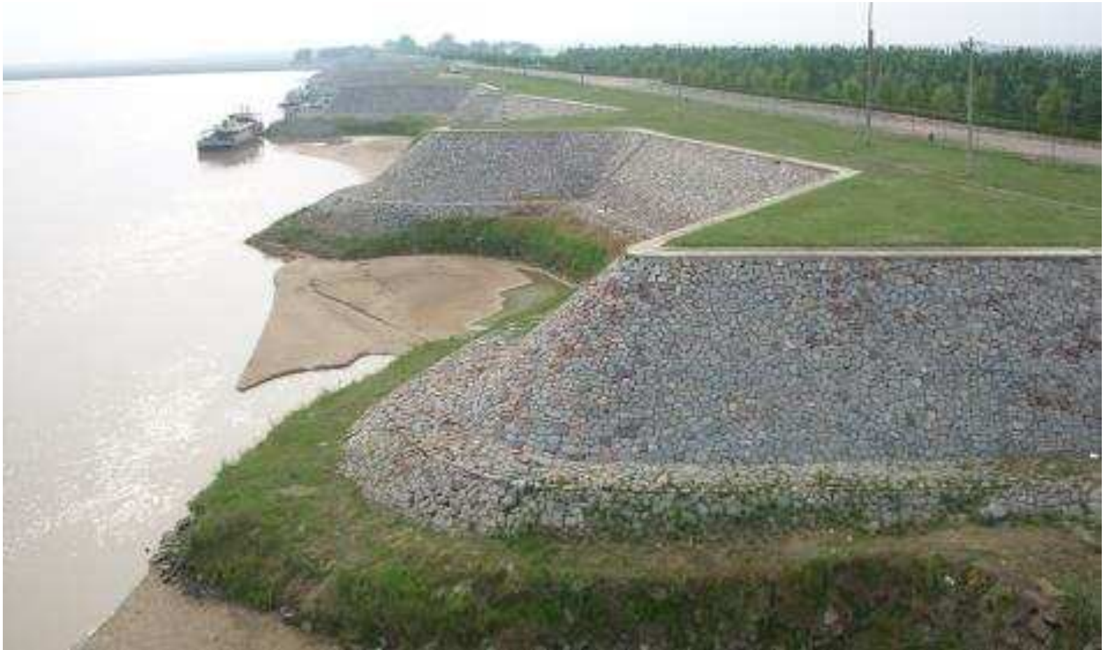
Берегозащитные сооружения на р. Хуанхэ – самые мощные в мире
