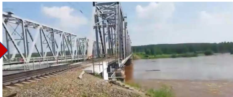
Ж/д мост на пике паводка
