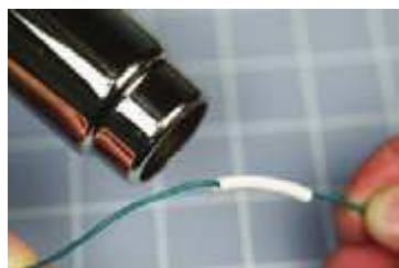
Рис. 3.43. С помощью промышленного фена начните разогрев трубки
